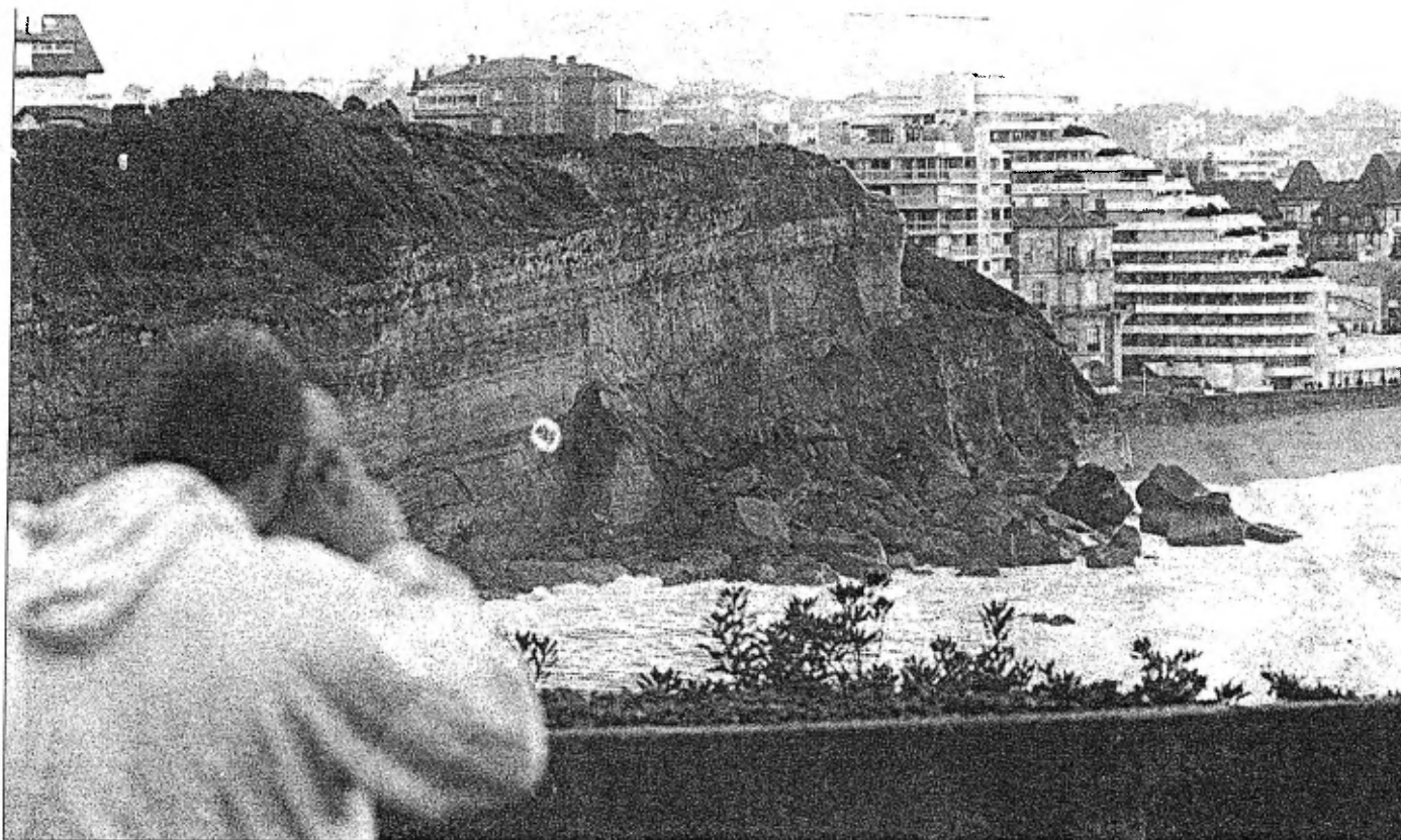
Sur la plage Bernain, entre le phare et le Miramar, 22 000 tonnes de roches se sont effondrées hier matin (Photo Patrick Bernière, « Sud-Ouest »).
